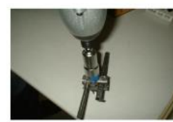
レンチで締めれば完成
